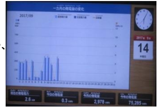
太陽発電モニター(昇降口)
