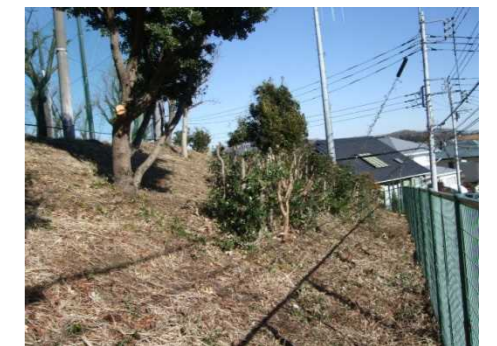
作業後の校庭南側外斜面
